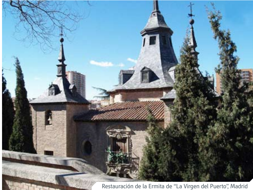
Restauración de la Ermita de "La Virgen del Puerto", Madrid
